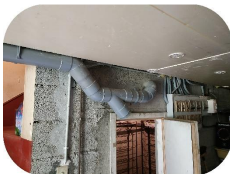
Sortie du ventilateur vers rejet extérieur en point haut
