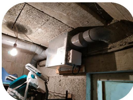
Sortie du ventilateur vers rejet extérieur en point haut
