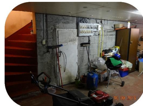
Escalier ouvert, murs en parpaings et porte local sous escaliers du garage
