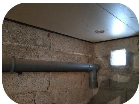
Conduit vers tranchée pour aspiration VS + ouverture cour anglaise garage
